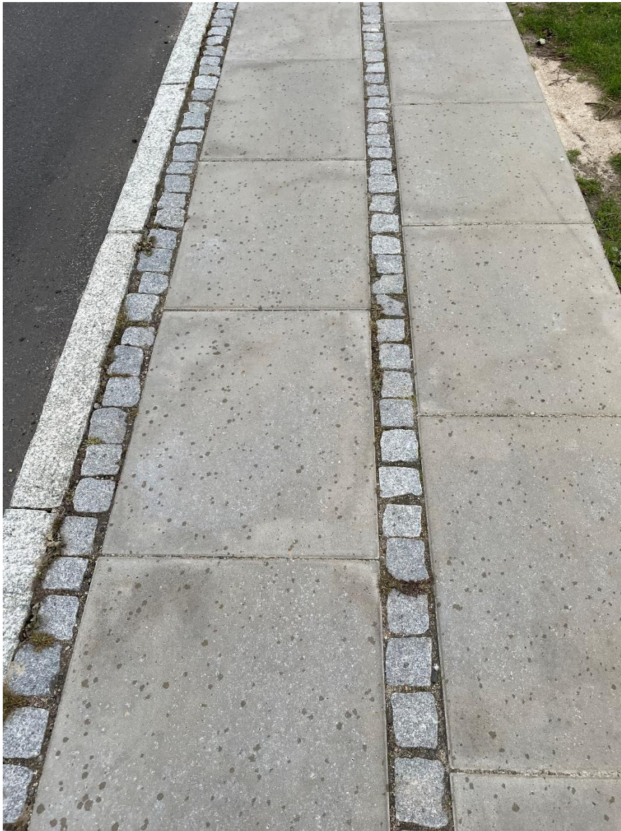
Figur 2. Referencebillede (Bredkær Tværvej). Fortov udført med chaussesten og granitkantsten.
